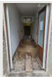
Vstupní prostory budovy pošty v průběhu zahájení rekonstrukce a po dokončení.
